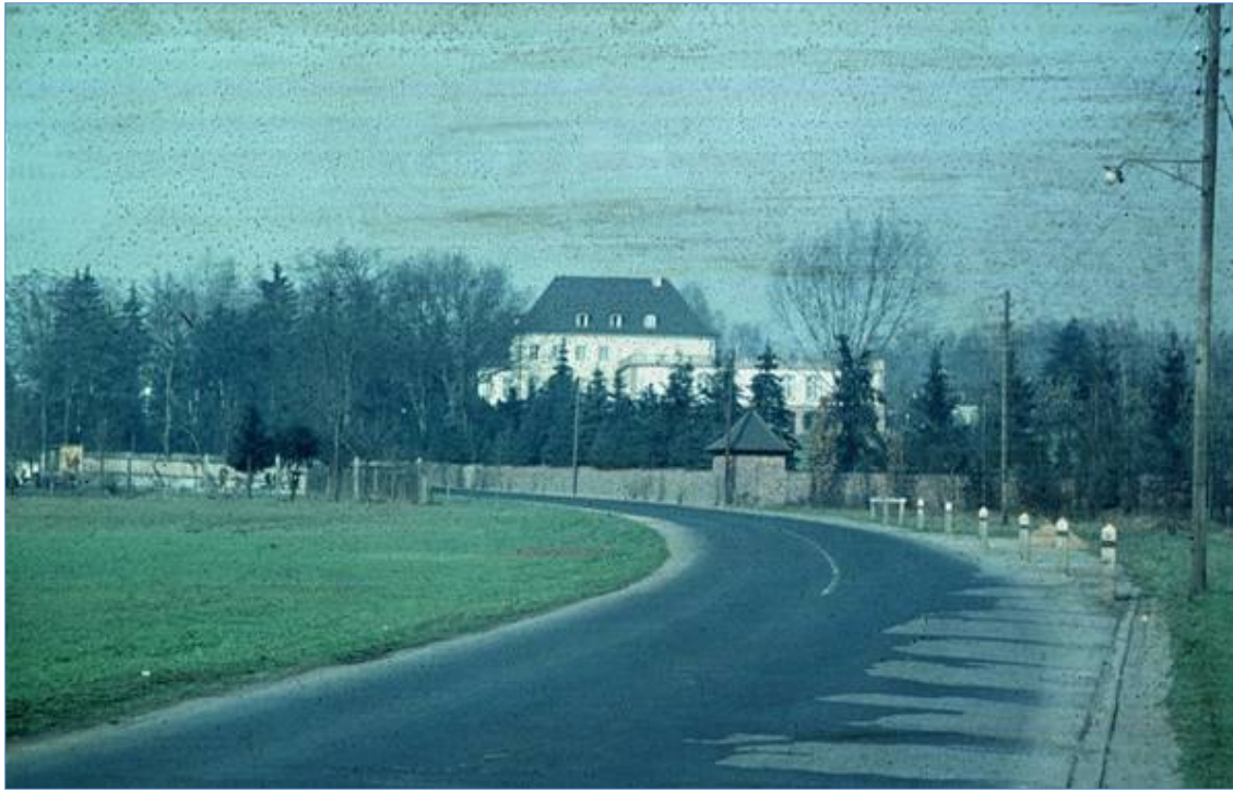
Schickedanz-Villa in den 1950er Jahren vom Talübergang Fuchsstraße aus gesehen. Foto: Stadtarchiv Fürth.
