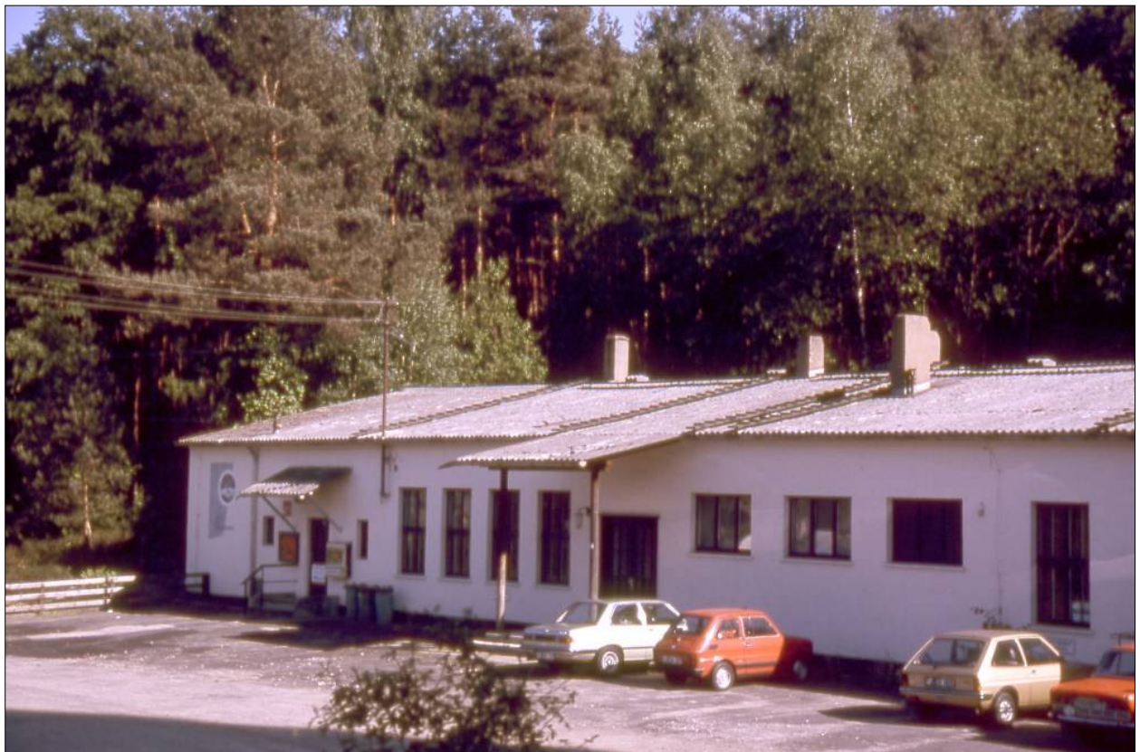
Häuserzeile der Heilstättensiedlung 1986
