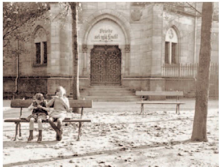
Erst nach und nach entstand die Wohnbebauung rund um die Paulskirche: Blick zur Fichtenstraße über die Felder (oben) und über die Amalienstraße (unten links). Der Spruch »Friede sei mit Euch!« ziert das linke Seitenportal. Fotografien nach 1900.
