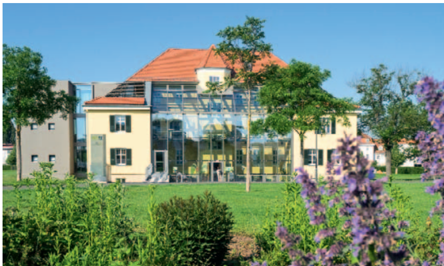
Die ehemalige Schickedanz-Villa stand nach den Konversionsplanungen mitten im Südstadtpark. Sie fand als Hochschule für Pflegemanagement der Diakonie Neuendettelsau eine neue Verwendung. Fotografie 2016.
