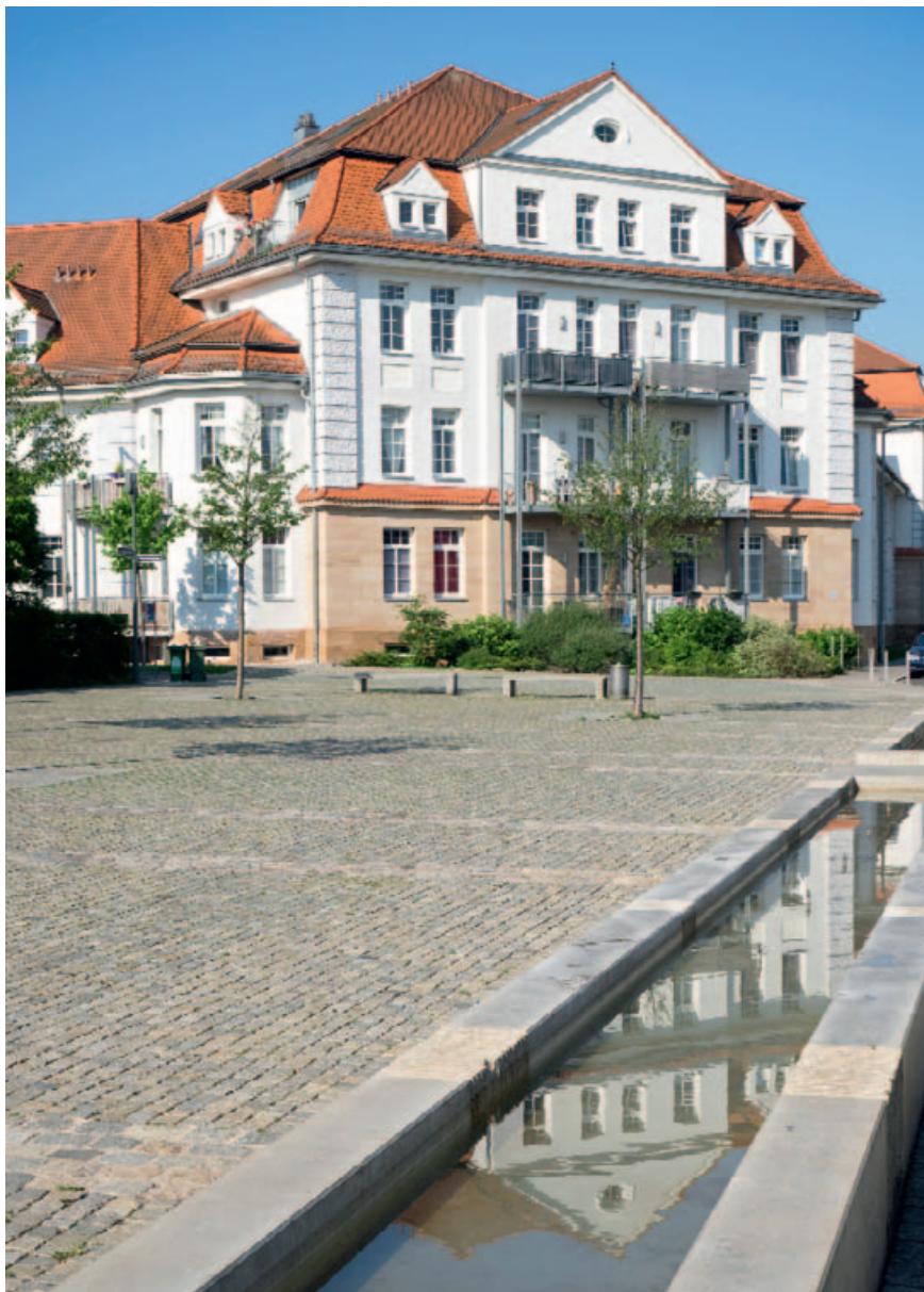
Die ehemalige Mannschaftsunterkunft mit renovierten Wohnungen dominiert den Marmarisplatz. Fotografie 2017.
