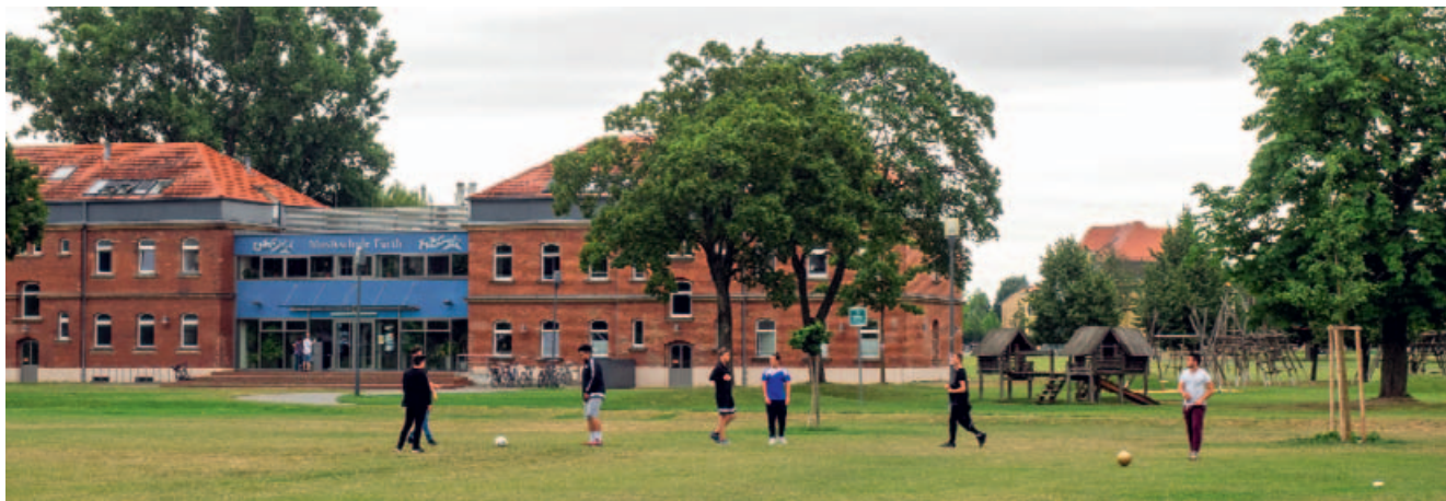
Zwei unter Denkmalschutz stehende Gebäude im Park wurden erhalten und durch einen Neubau verbunden. In ihnen fand die Fürther Musikschule ein neues Quartier. Fotografie 2016.
