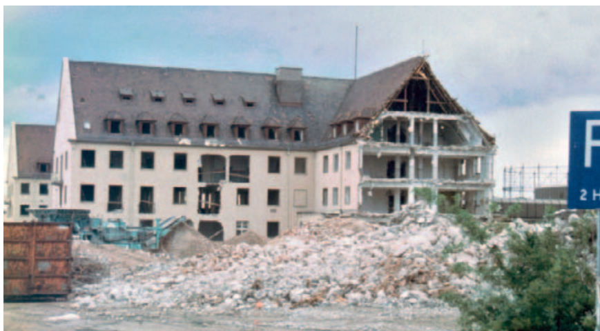
Im Jahr 2000 begann der Abriss des ehemaligen Wehrmachtgebäudes.
