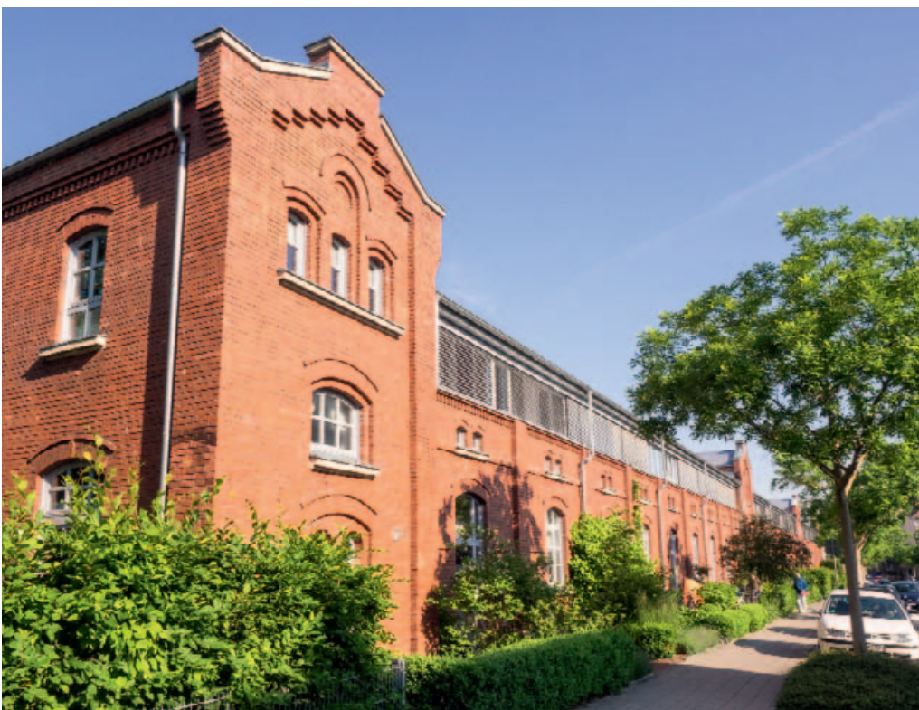
Das ehemalige Stallgebäude, die spätere Kfz-Unterstandshalle, wurde zu attraktiven Reihenhäusern umgebaut. Fotografie 2016.
