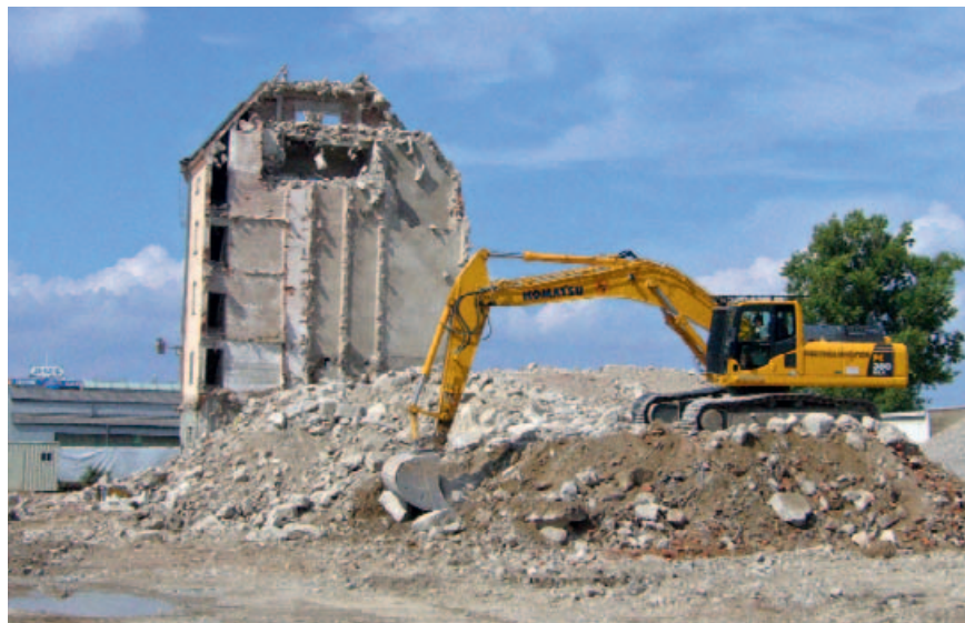
Die letzte der ursprünglichen Wehrmachts-Lagerhallen in den Johnson-Barracks wird 2007 abgerissen.
