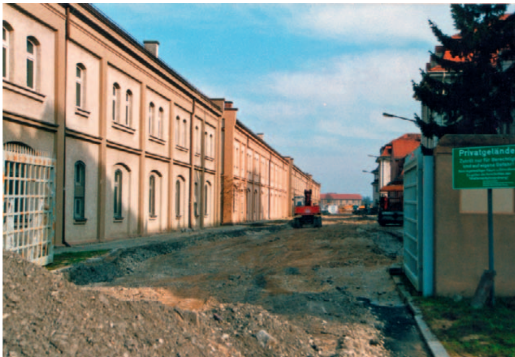
Ausbau der Isaak-Loewy-Straße, Fotografie 2002.
